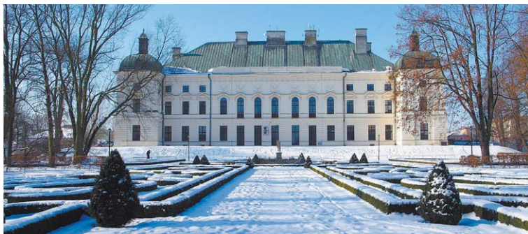
Jednym z szeregu przedsięwzięć, jakie planują władze powiatu lubartowskiego jest remont dachu i kominów na zabytkowym Pałacu Sanguszków; siedzibie miejscowego starostwa
