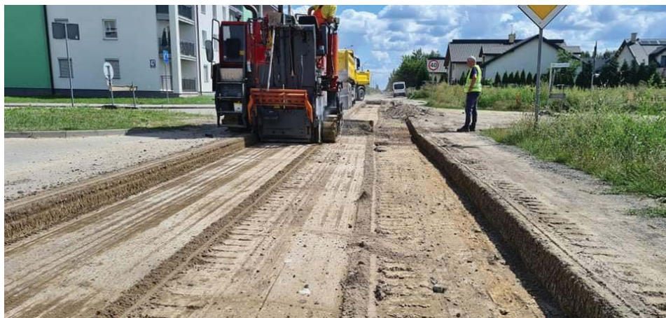
Remont ulicy Podmiejskiej trwa
