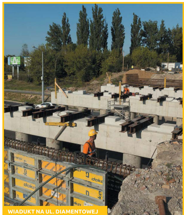
WIADUKT NA UL. DIAMENTOWEJ
