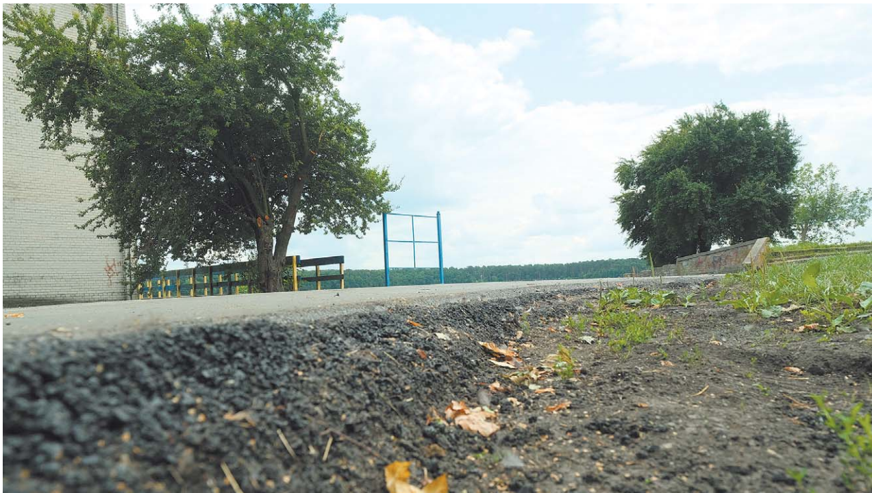
Na remont, przebudowę i rozbudowę alejek nad zalewem pieniędzy nie zabrakło
