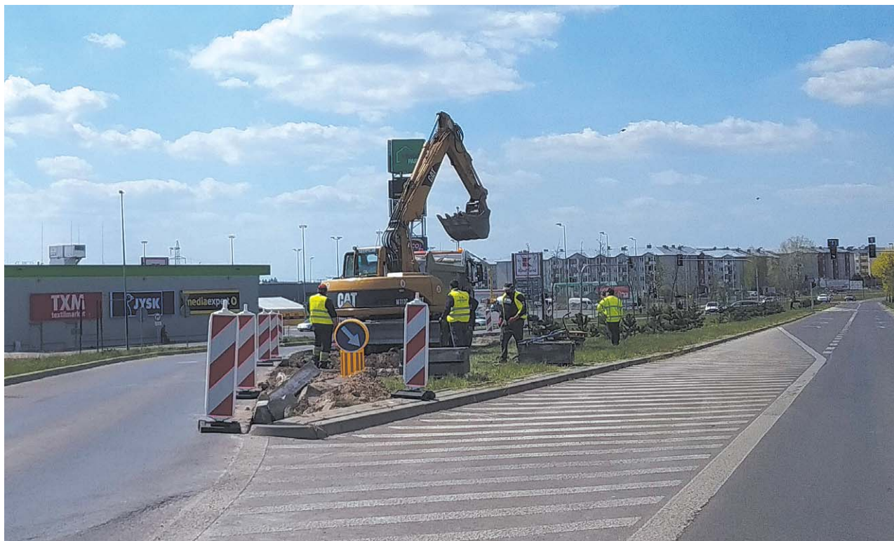
Ruszyła budowa nowego pasa alei 3 Maja
