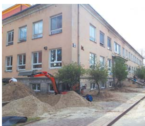
Szpital i prace remontowe FOT. ARCH. DW
