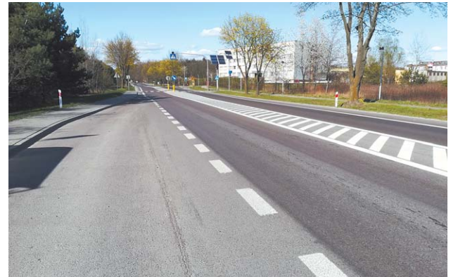
Na odcinku drogi krajowej nr 19 od ul. Ceramicznej w kierunku ul. Przemysłowej w Niemcach prace będą przeprowadzone prawdopodobnie w tym roku FOT. GDDKIA
