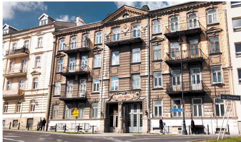
Fasada eklektycznej kamienicy przy ul. 3-go Maja 22
