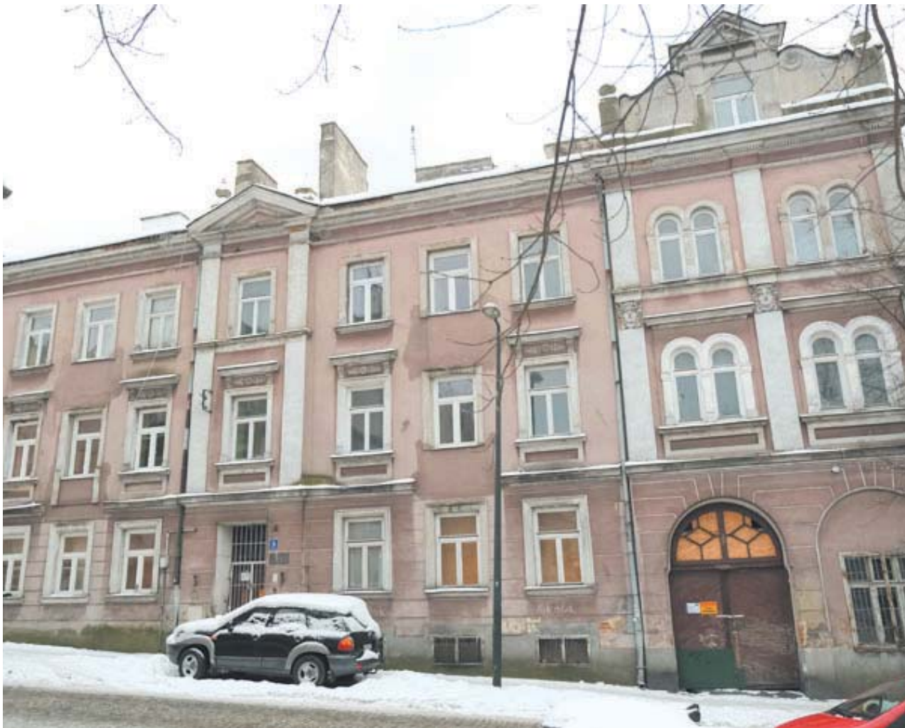
Kamienica składa się z trzech części. Mające po cztery kondygnacje budynek frontowy i oficyna zachodnia zostały wybudowane w latach 1904-1905. Dwukondygnacyjna oficyna wschodnia jest nieco starsza
