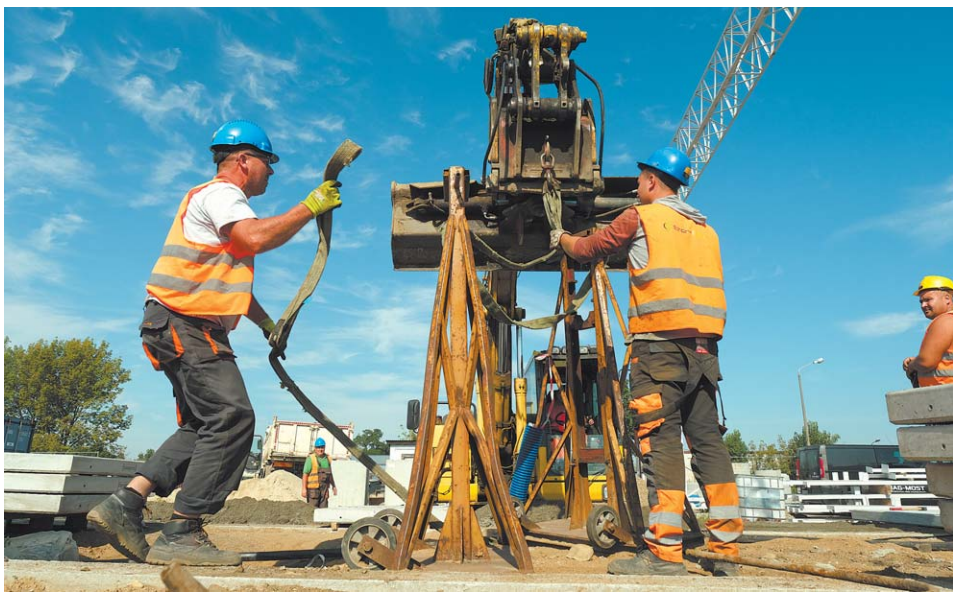
Przebudowa stacji Lublin Główny ma się zakończyć w marcu 2021 r. – deklaruje kolej
