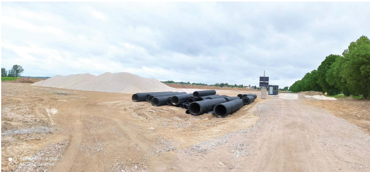
Zaplecze budowy A2 pomiędzy Ciciborem Dużym a Białą Podlaską
