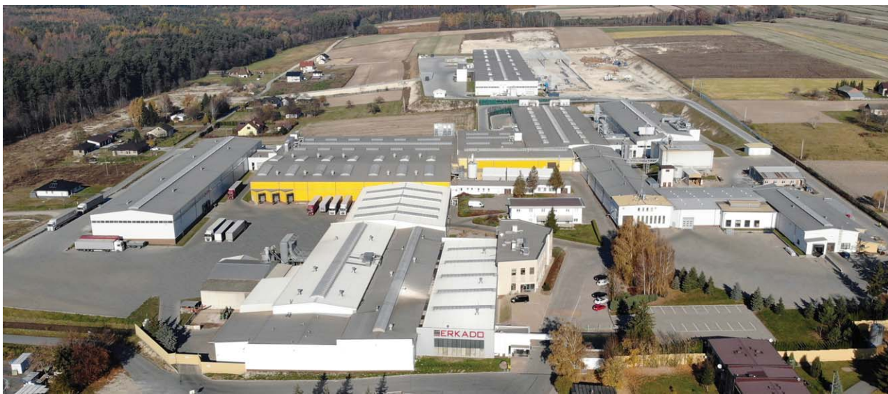
W zeszłym roku w zakładach produkcyjnych w Gościeradowie wybudowano m.in. nową halę produkcyjną
