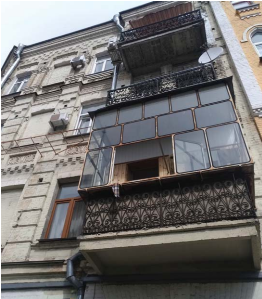
W Kijowie praktycznie każda firma, która produkuje okna, robi też zabudowy balkonów
