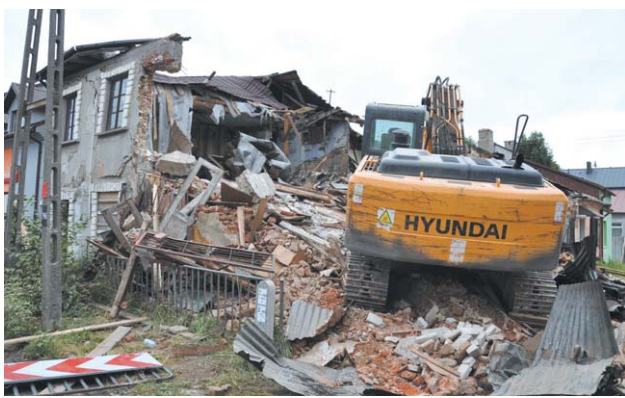
Wyburzanie starej kamienicy przy Rynku II w Łęcznej
