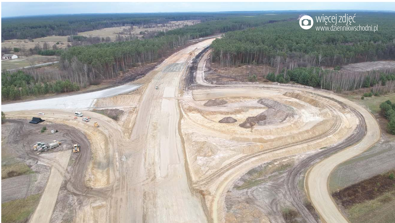
Prace przy budowie trasy na odcinku między Kraśnikiem a Lasami Janowskim
