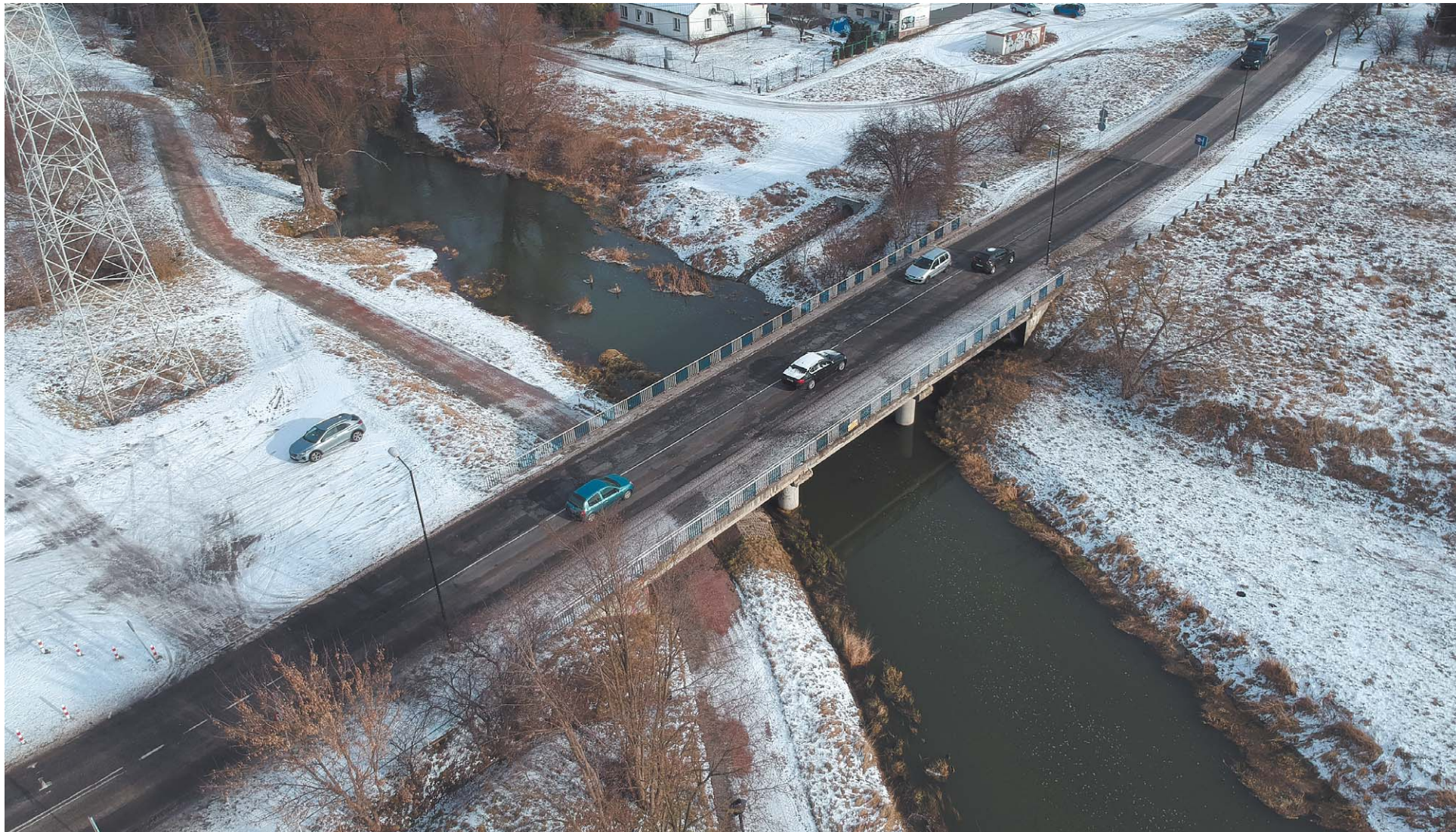
Zarząd Dróg i Mostów ogłosił już przetarg na wymianę mostu i przebudowę odcinka ul. Żeglarskiej
