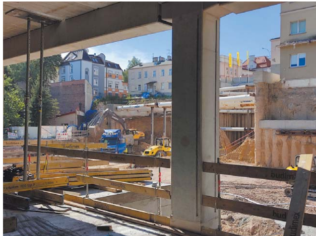
Po prawej nowy budynek, w tle na skarpie zabudowania przy Staszica 16
