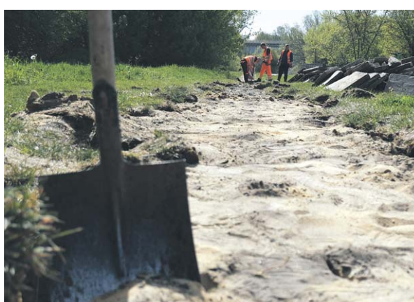
Prace przy remoncie ul. Janowskiej rozpoczęły się
