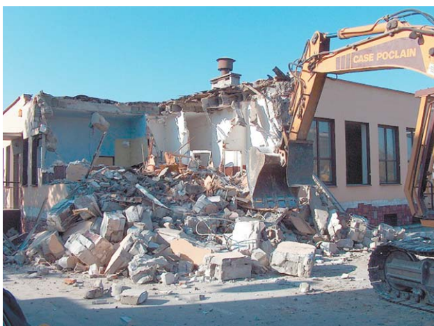
Tak w 2005 roku wyglądało wyburzenie restauracji „Złoty Kur” pod sklep Biedronka w Kurowie przeprowadzone przez przedsiębiorstwo Świstrans
