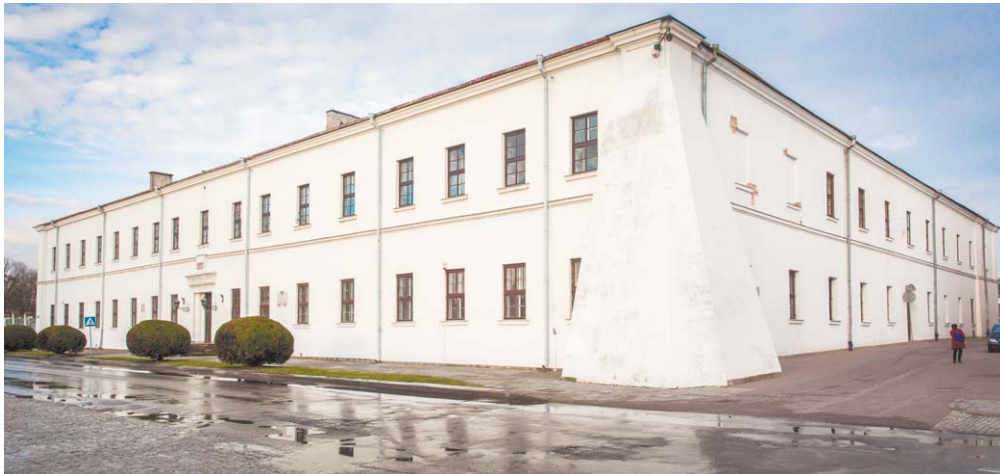
Budynek Akademii Zamojskiej to charakterystyczny, czteroskrzydłowy gmach z wewnętrznym dziedzińcem na Starym Mieście
