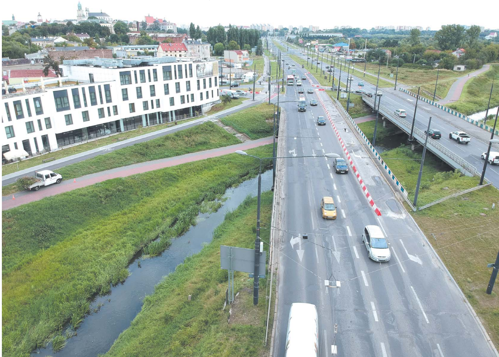
Planowana przebudowa ma objąć m.in. wymianę dwóch mostów na Bystrzycy, które są w fatalnym stanie technicznym.
