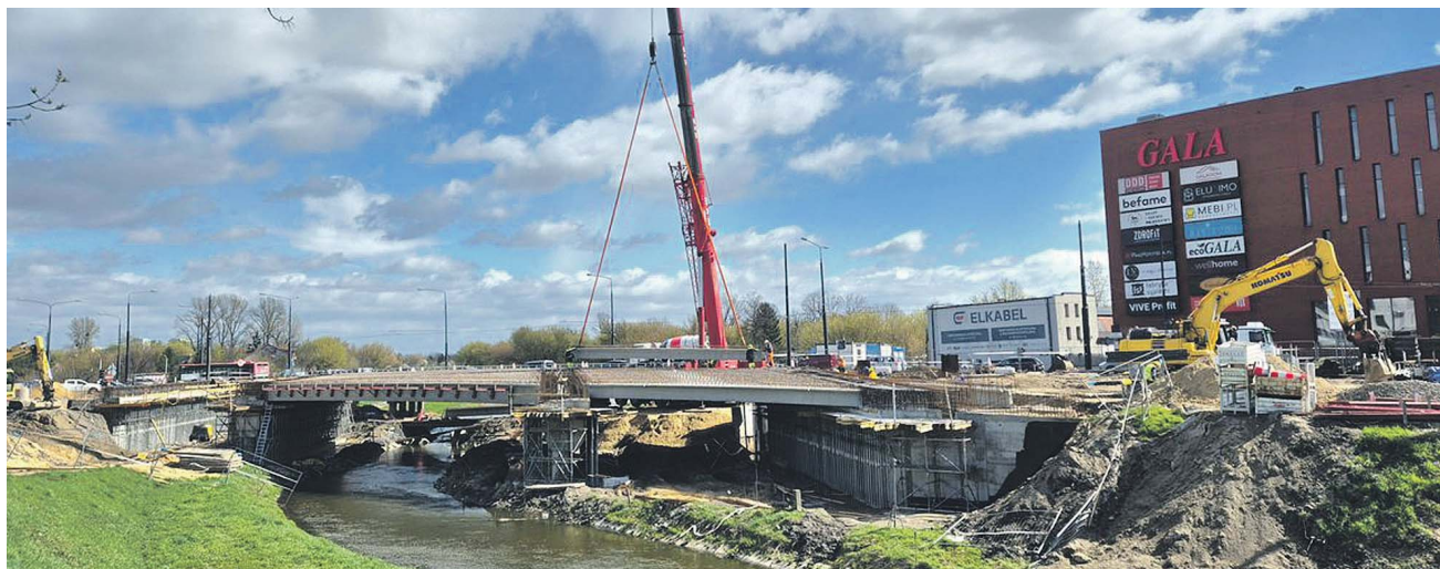
Obecny etap remontu to montaż wielkogabarytowych dźwigarów
