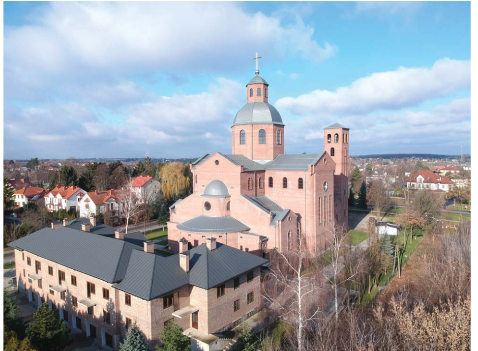
Ul. Nałęczowska. Budowa kościoła Trójcy Świętej
