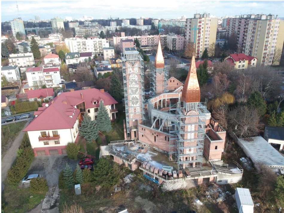
Budowa kościoła Przemienienia Pańskiego przy ul. Nowomiejskiej
