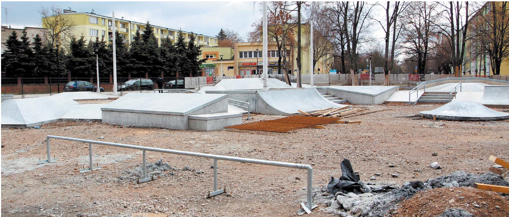
Część placu jest już gotowa, pokryta specjalnym, zaimpregnowanym, gładkim betonem
