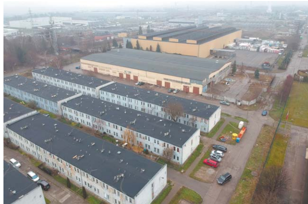
W hali przy ul. Metalurgicznej 9 b mają być zainstalowane maszyny przetwarzające odpady z tworzyw sztucznych, głównie z folii, na granulaty
