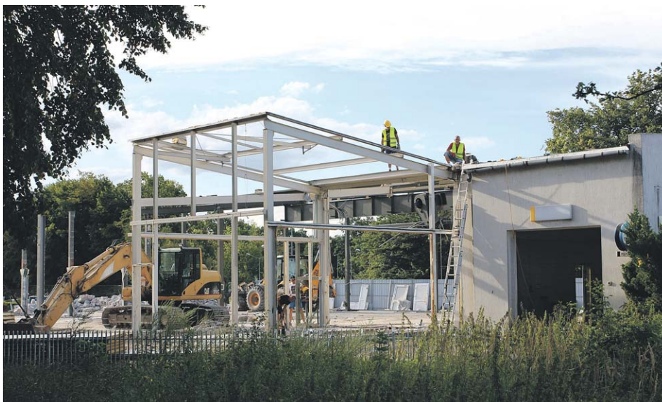
Przy Lubelskiej prowadzone są już prace rozbiórkowe. Budynek salonu samochodowego znika, by ustąpić miejsca dyskontowi spożywczemu
