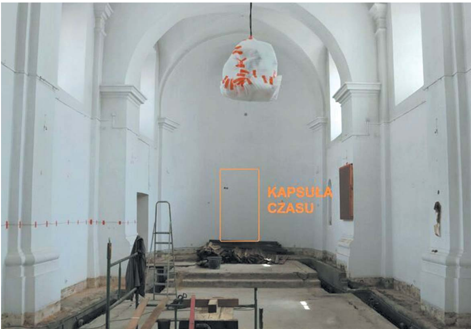
Miejsce zamurowanego przejścia
