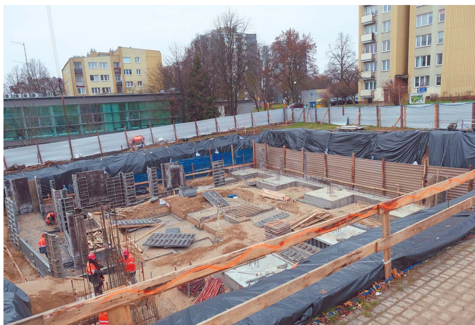
A tak wygląda plac budowy między ul. Filaretów a biurowcem będącym siedzibą Regionalnego Zarządu Gospodarki Wodnej
