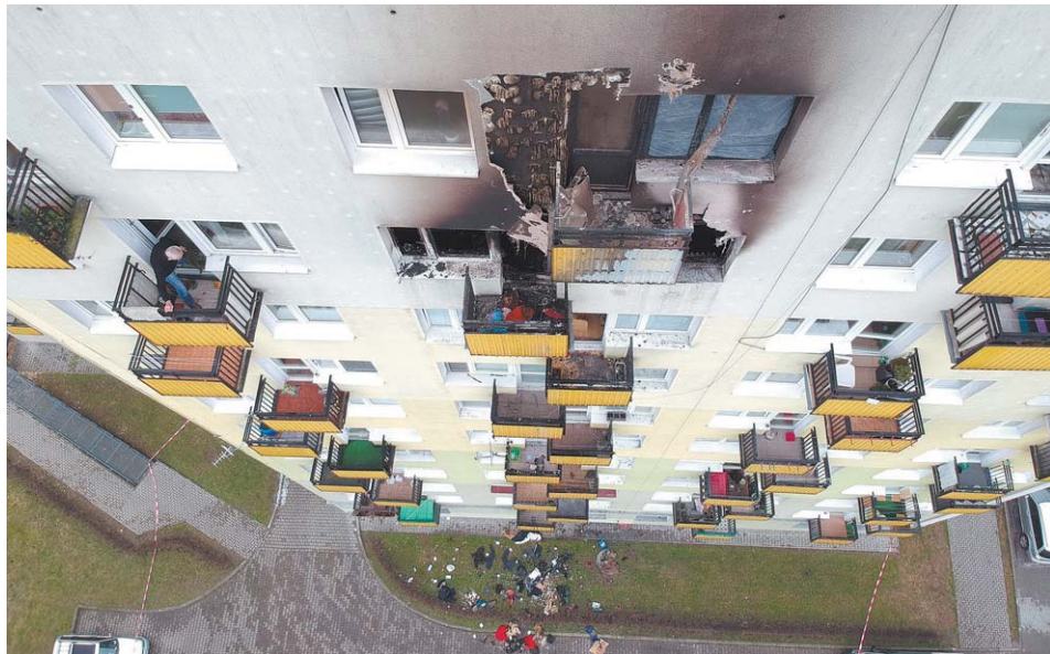
Pożar na przedostatnim piętrze wieżowca przy ul. Raławickiej w Świdniku wybuchł w środę wieczorem, 30 grudnia
