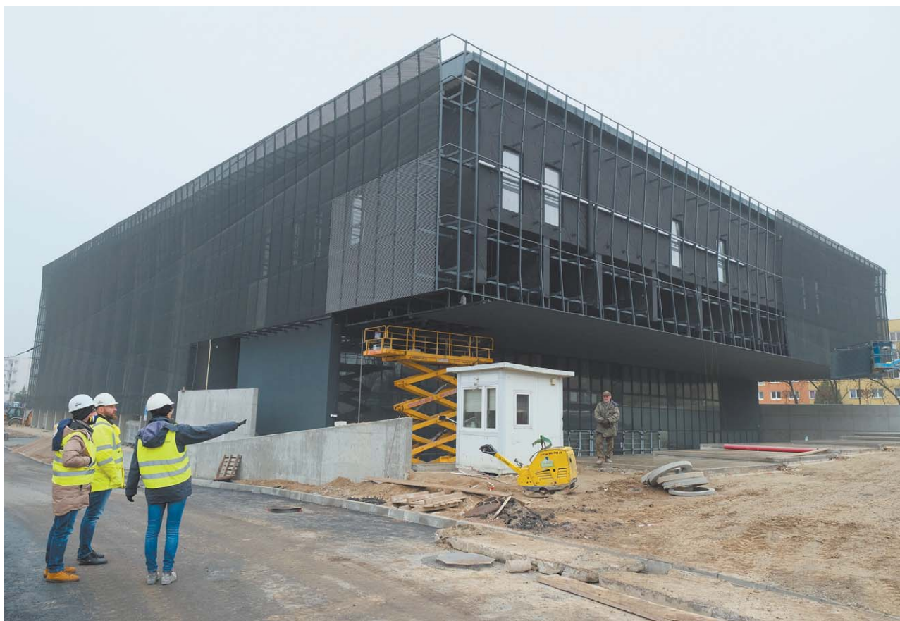
Termin ukończenia robót nie jest zagrożony. Hala będzie gotowa w lutym
