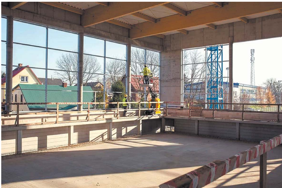
Basen w Hrubieszowie powstaje przy Szkole Podstawowej nr 2 na ul. Żeromskiego. Zakończenie inwestycji zaplanowano na marzec 2022
