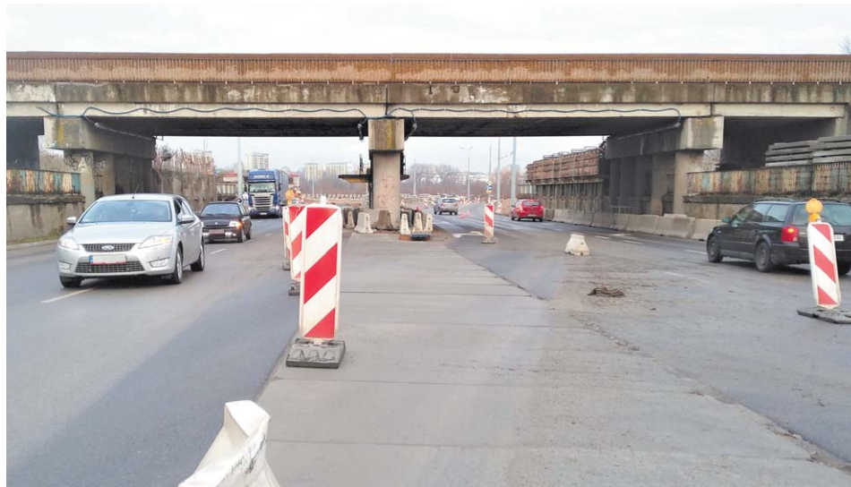
Obie jezdnie pod wiaduktem kolejowym są już otwarte
