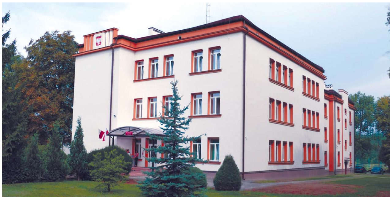
Szkoła w Kluczkowicach po wykonaniu ocieplenia
