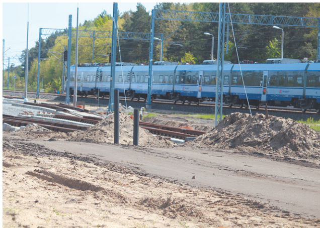
Budowa przystanku Biała Podlaska Wschodnia
