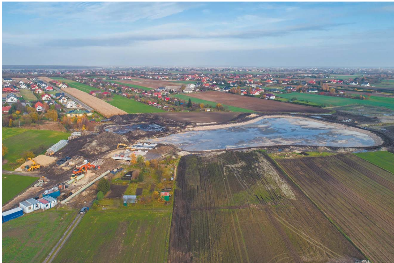
Zbiornik, którego budowa ma się zakończyć za kilka miesięcy, ma mieć powierzchnię niecałych 2 ha (1,77 ha) i średnią głębokość 1,41 m.
