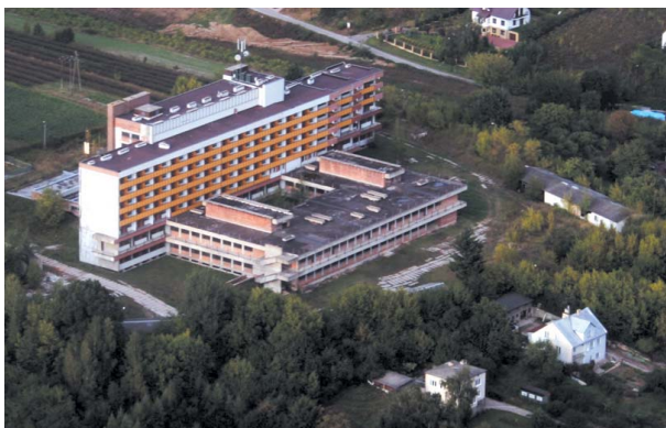
Budowę nałęczowskiego, państwowego sanatorium Ministerstwo Spraw Wewnętrznych rozpoczęło w 1983 roku i nigdy nie ukończyło
