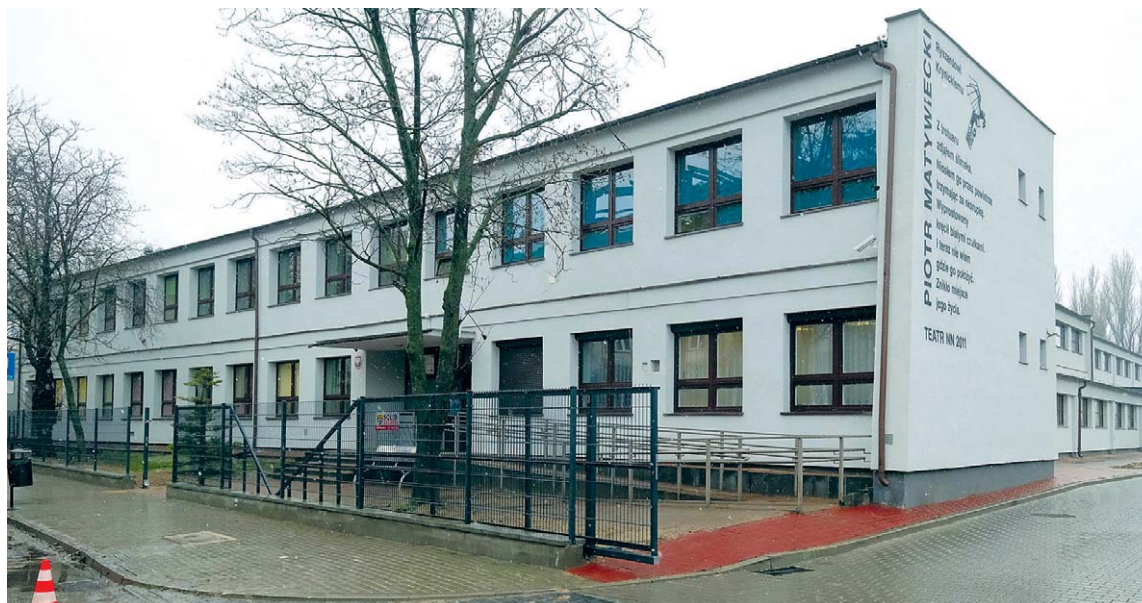
Na parterze budynku przy ul. Farbiarskiej są przedszkolaki. Teraz nad nimi mają uczyć się dzieci z podstawówki
