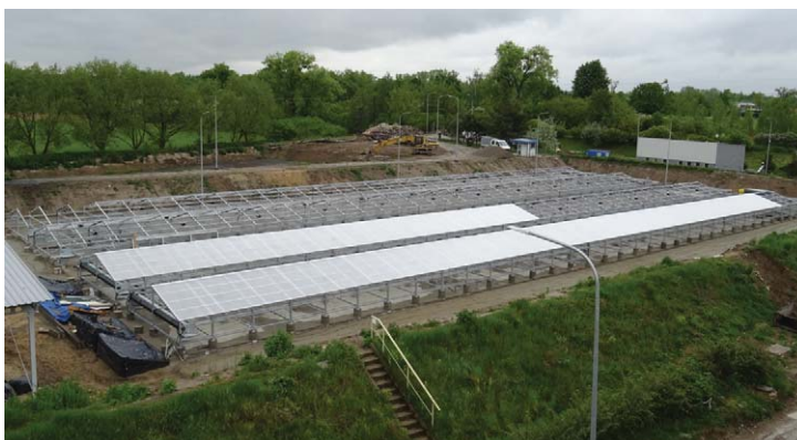
Oczyszczalnia dzięki pełnej modernizacji, wymianie i doposażeniu w nowe urządzenia będzie mogła przyjąć i oczyścić całą przewidywaną docelowo ilość ścieków.
