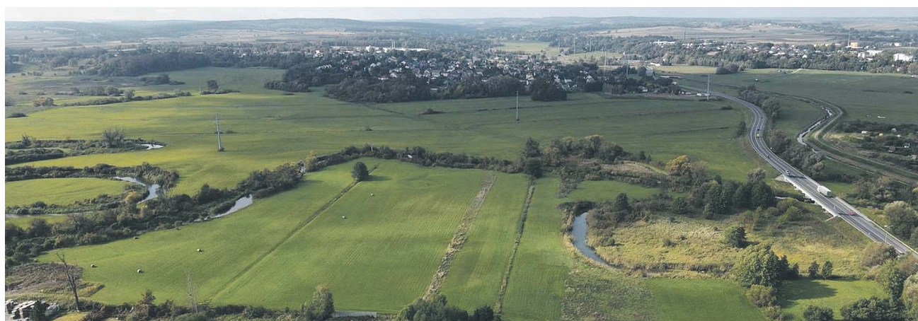
O kontrakt na budowę 19 km S17 walczyło 12 firm
