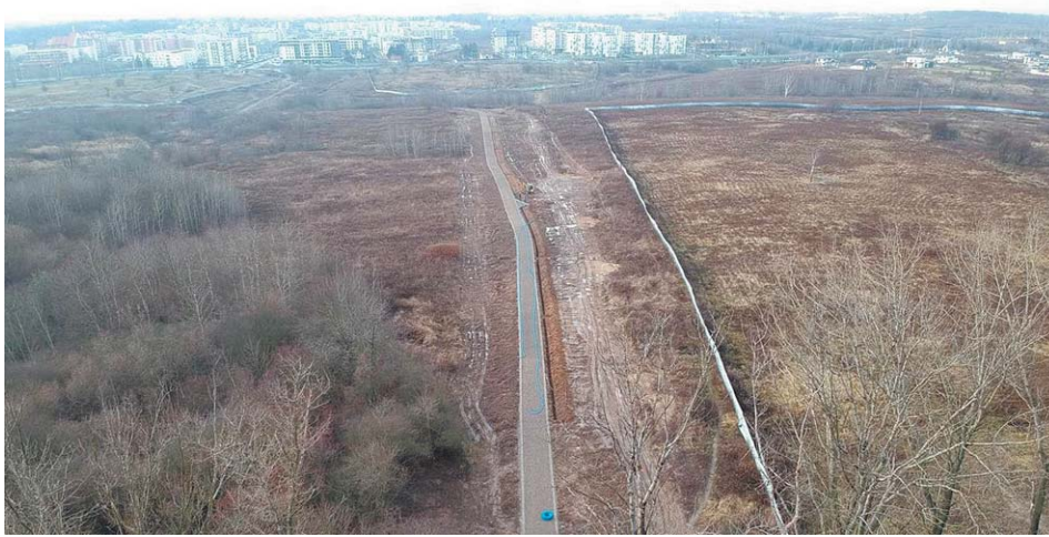
Górki czechowskie nie wyglądają już tak, jak w dniu pierwszego wyroku. Od tamtej pory spółka TBV Investment, w oparciu o prawomocne pozwolenie na budowę wydane przez Urząd Miasta, zdążyła tu wykonać alejkę łączącą Czechów ze Sławinem
