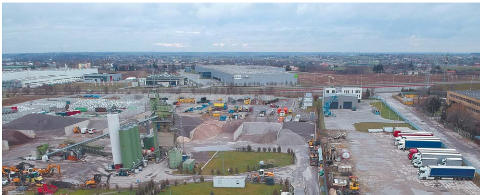
Punkt zbierania odpadów miałby powstać w miejscu wytwórni mas bitumicznych przy ul. Metalurgicznej, 350 m od najbliższych domów mieszkalnych
