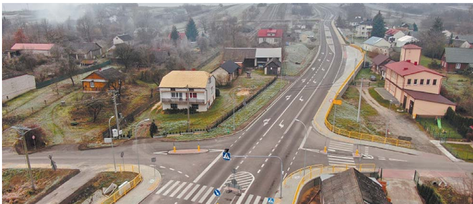
Wyremontowany fragment DK74 Frampol-Gorajec
