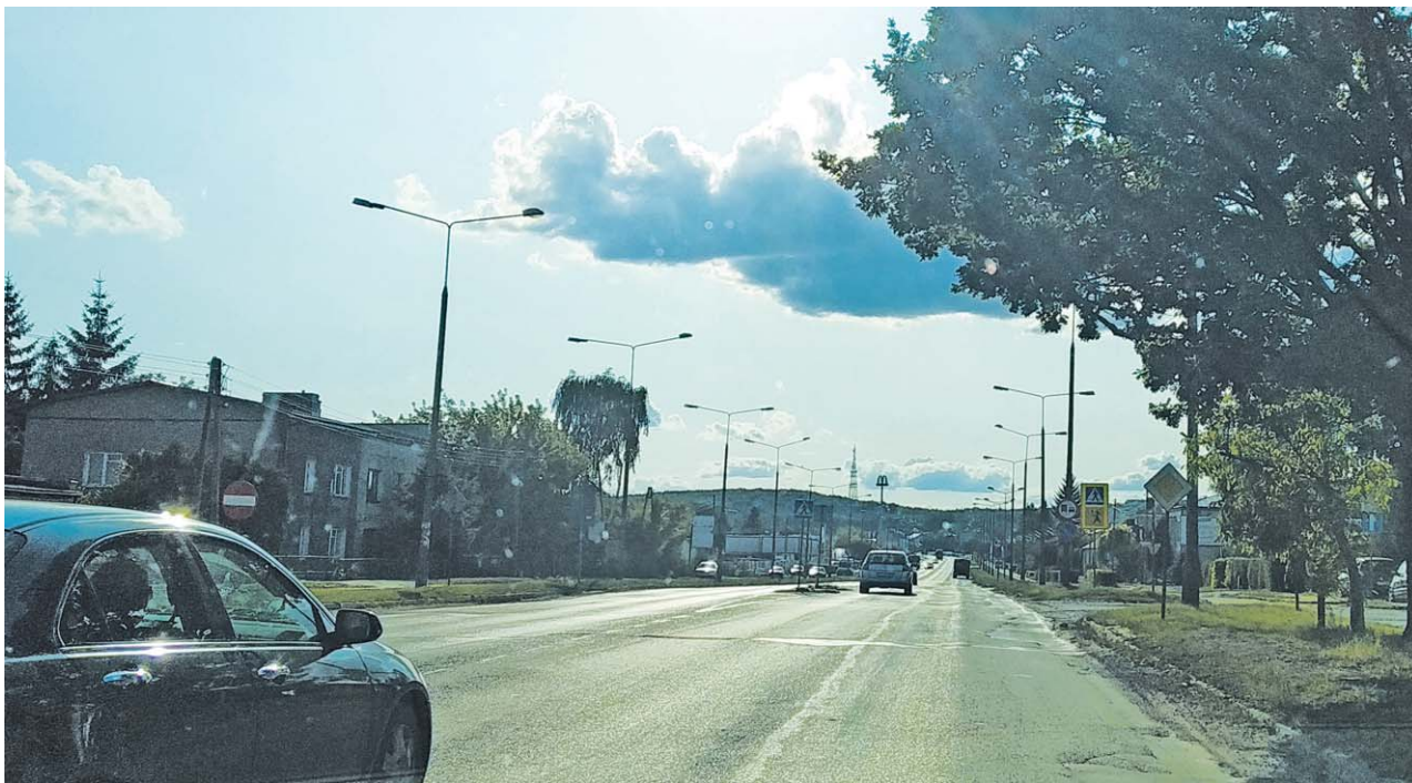
Gruntowny remont ul. Rejowieckiej i odcinka ul. Okszowskiej ma się zakończyć do 31 października 2021 roku
