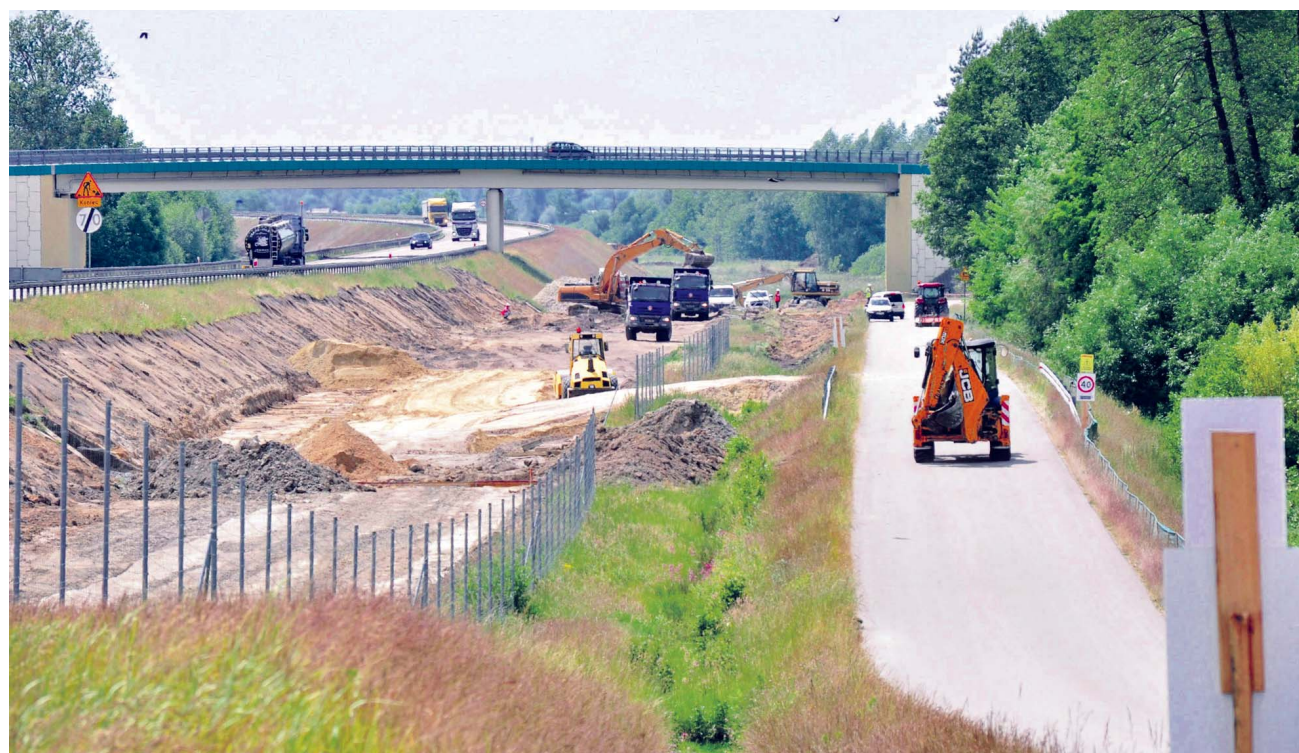
Budowa drugiej jezdni obwodnicy Kocka i Woli Skromowskiej
