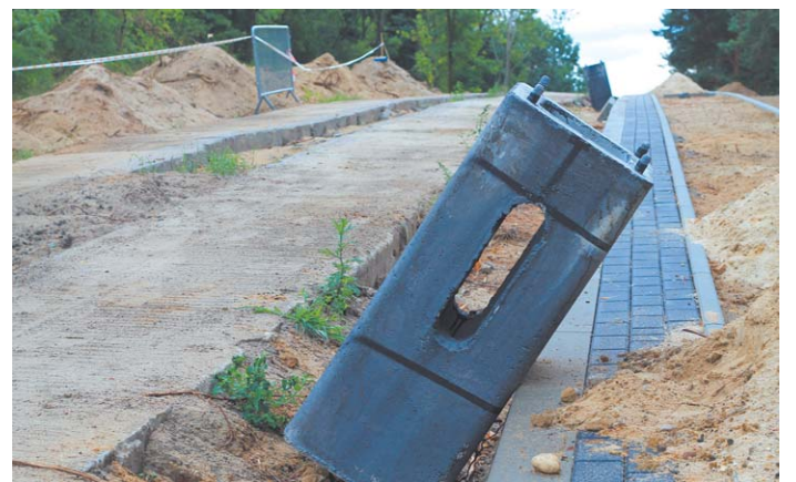
Najwięcej nawierzchni z betonowych płyt jest na os. Włostowice. Na zdjęciu przebudowywana właśnie ul. Powstańców Listopadowych
