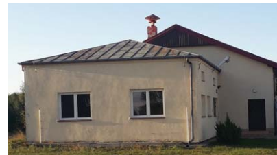
Na potrzeby Centrum Społeczno-Kulturalnego w Sobolach przebudowano budynek OSP
