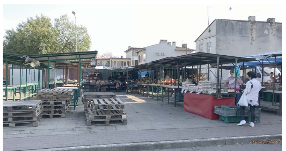
Powstaną tu zadaszone miejsca handlowe, a istniejące budki będą rozebrane. Płyty chodnikowe zastąpi bruk betonowy
