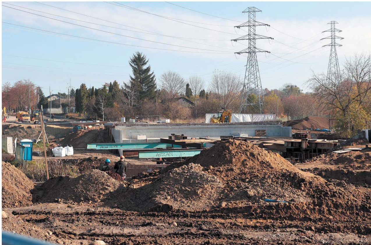
Wymiana mostu kosztuje miasto 36,6 mln zł. Starego już nie ma, budowa nowego potrwa dłużej niż zakładano
