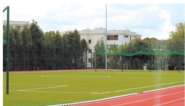
Firma Tamex starająca się o kontrakt z Gminą Puławy odpowiadała m.in. za budowę otwartych w 2016 roku boisk przy SP nr 11 w Puławach
