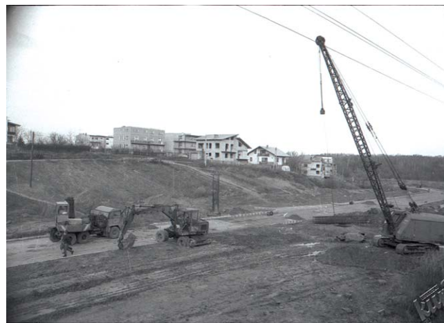
Budowa ul. Sikorskiego FOT. TEATR NN, MACIEJ KACZANOWSKI
