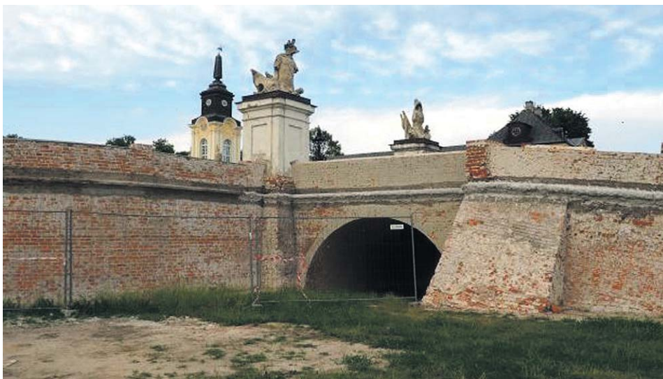
Mury oporowe też trzeba było wyremontować
