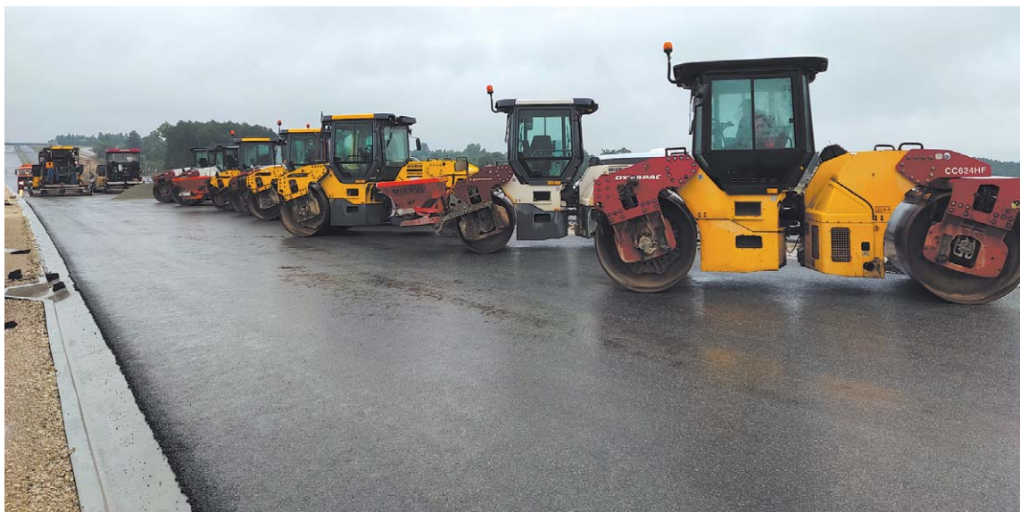
Budowa 42-kilometrowego odcinka S19 ma kosztować 1,48 mld zł
