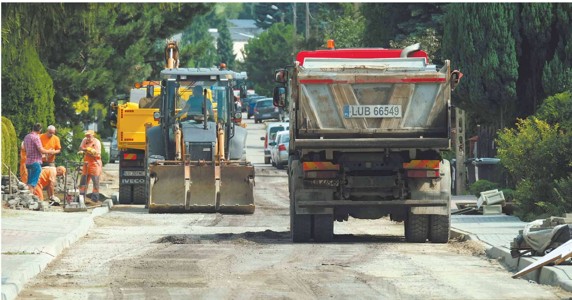
Trwający remont ul. Namysłowskiego to jedna z inwestycji realizowanych w ramach ostatniej edycji budżetu obywatelskiego
