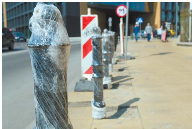
Okolice budynku KUL przy Spokojnej
