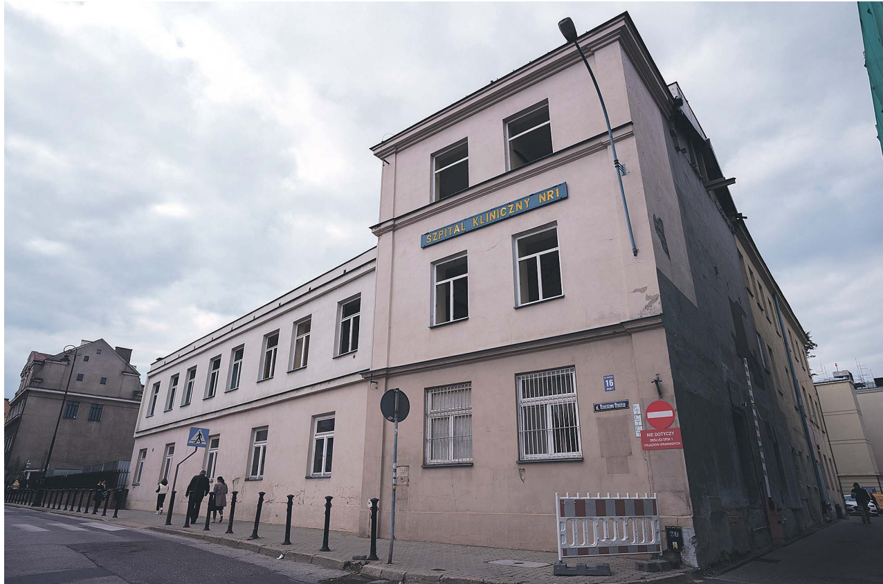
Te budynki mają być rozebrane w ciągu kilku dni
