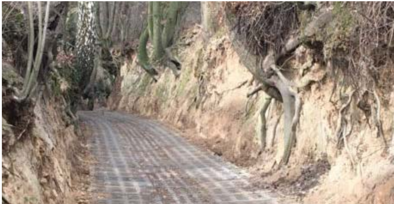
Wąwóz Czarny został już wyłożony ażurowymi betonowymi płytami. Urząd Miasta nie zmienił w tej sprawie decyzji mimo protestów i petycji przeciwko utwardzeniu wąwozu, którą podpisało ponad 2 tysiące osób z całej Polski
