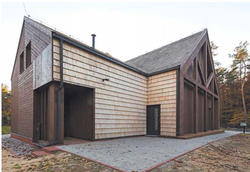
Budynek administracyjny w Żdżarach w całości (z wyjątkiem żelbetowej płyty fundamentowej) wykonany jest z drewna
