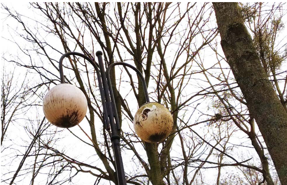
Niektóre latarnie w Chełmie są w opłakanym stanie. Oprawy są tak brudne, że nawet jak żarówka świeci, to i tak nic nie widać na chodniku czy ulicy
