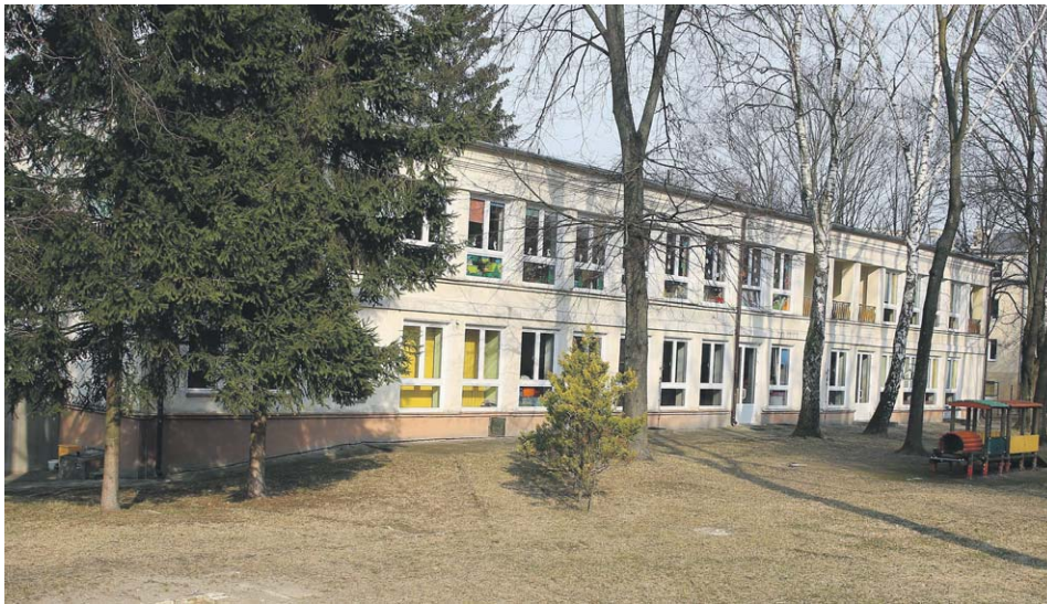
Budynek z pierwszej połowy lat 50 może być wyremontowany lub wymieniony na nowy. O ile będzie projekt i znajdą się pieniądze
