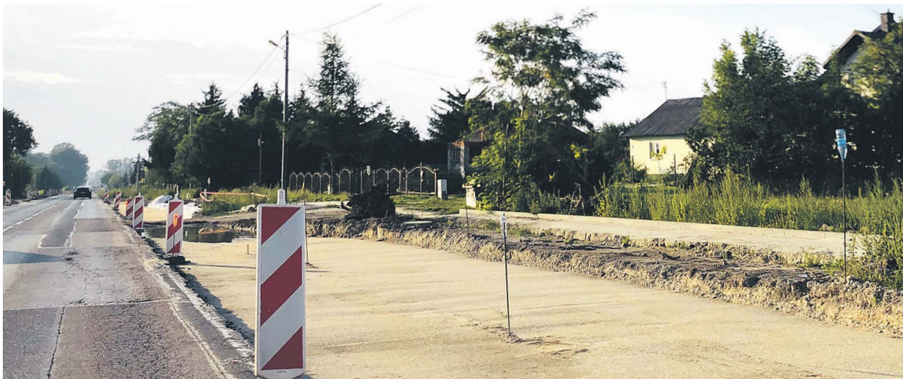
Inwestycja trwa sporo ponad rok, ale na trasie trudno znaleźć miejsca, które wyglądałyby na gotowe
